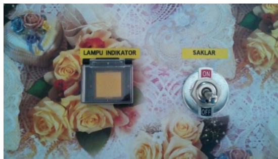
Gambar 18. Kondisi Saklar Off
