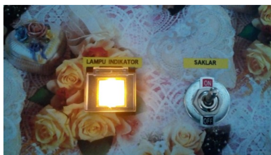
Gambar 19. Kondisi Saklar On
