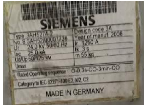
Gambar 3. PMT 20 KV Vacuum (a) dan Nameplate (b)
