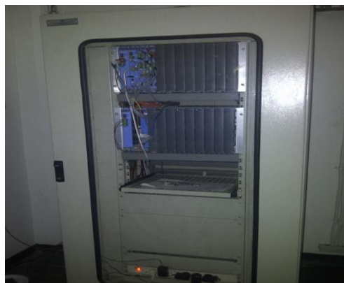
Gambar 14. RTU dengan Media Komunikasi Fiber optik
