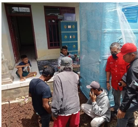
Gambar 3. Tim Pengabdian Dan Warga Bergotong Royong Melakukan Pemasangan Toilet Portable
