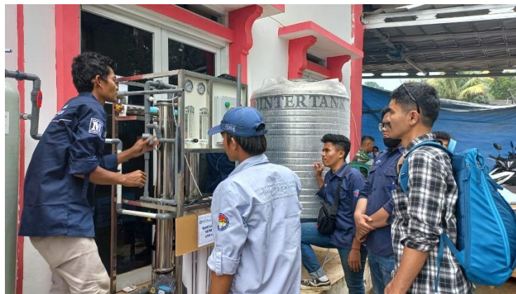
Gambar 4. Proses Instalasi Alat
