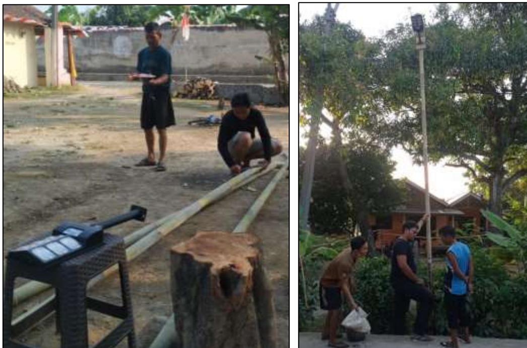
Gambar.. Pemasangan lampu penerangan jalan menggunakan LED dengan sumber listrik dari energi surya
