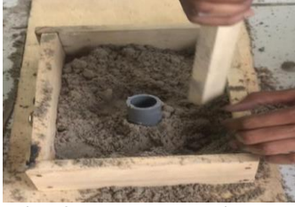
Gambar 3.9 Proses Pemasangan Pasir
