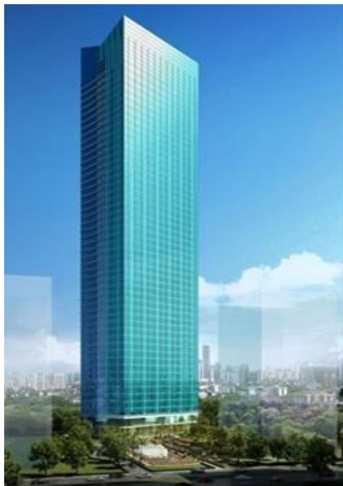
Gambar 1. Tampak depan gedung millenium centenial center
