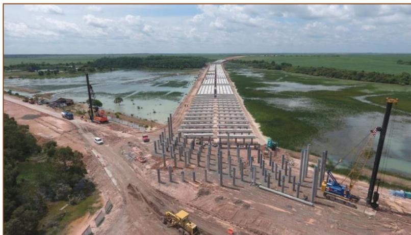
Gambar 1. Pembangunan Jalan Tol Trans Sumatera
