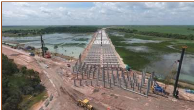
Gambar 1. Pembangunan Jalan Tol Trans Sumatera
